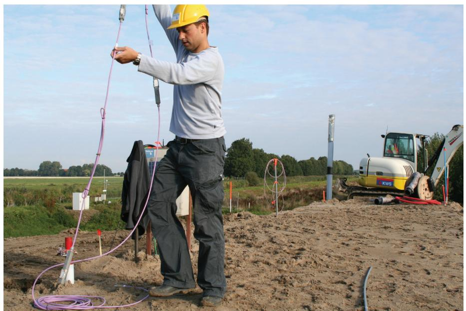
Figuur 1. GeoBeads worden in de dijk geplaatst
